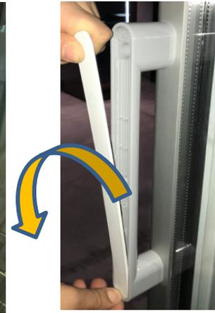
Svitare tramite un cacciavite a croce le due viti di fissaggio per rimuovere la maniglia.
