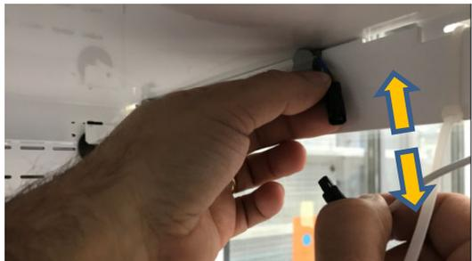
Sganciare la lampada per la sostituzione esercitando una trazione con rotazione nel verso indicato, avendo cura di rimontarle correttamente con operazioni inverse.
